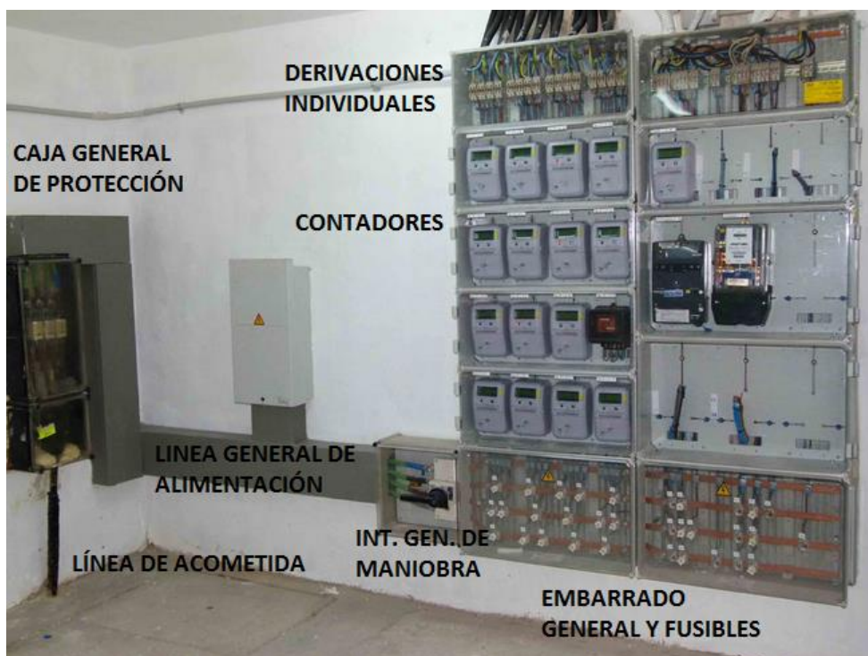
Figura 17. Esquema de instalación completa: CGP a derivación individual. Fuente: CBCM
