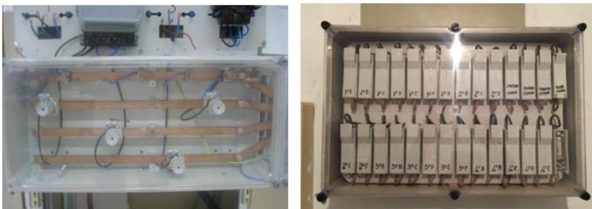
Figura 15. Embarrado y fusibles de protección. Fuente: CBCM
