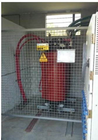
Figura 8. Transformador. Fuente: CBCM
