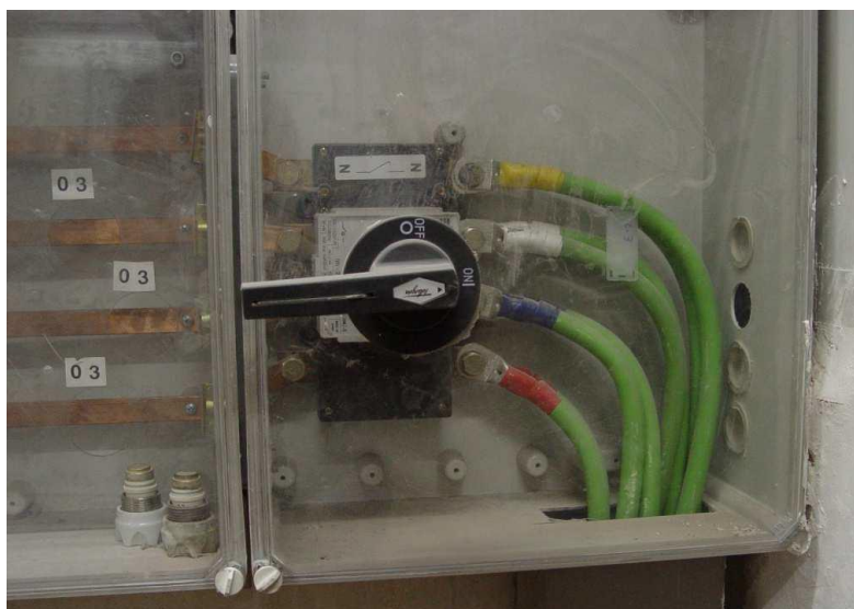
Figura 14. Interruptor de corte en carga. Fuente: CBCM
